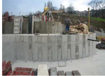
Kaskadenstufen im Rohbau
