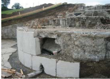
Abbruch und Abbau der Kaskadenstufen
