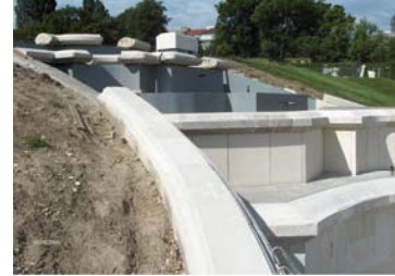
Kaskadenstufen im Wiederaufbau
